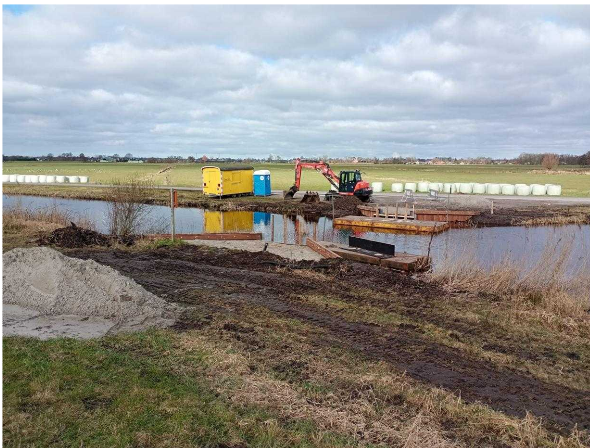
De werkzaamheden aan het nieuwe bruggetje vorderen ondertussen gestaag!
